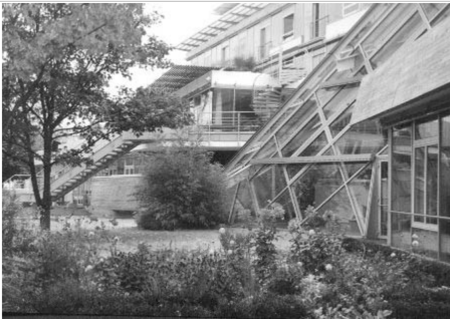
Blick auf den repräsentativen Eingang des St. Benno-Gymnasiums
