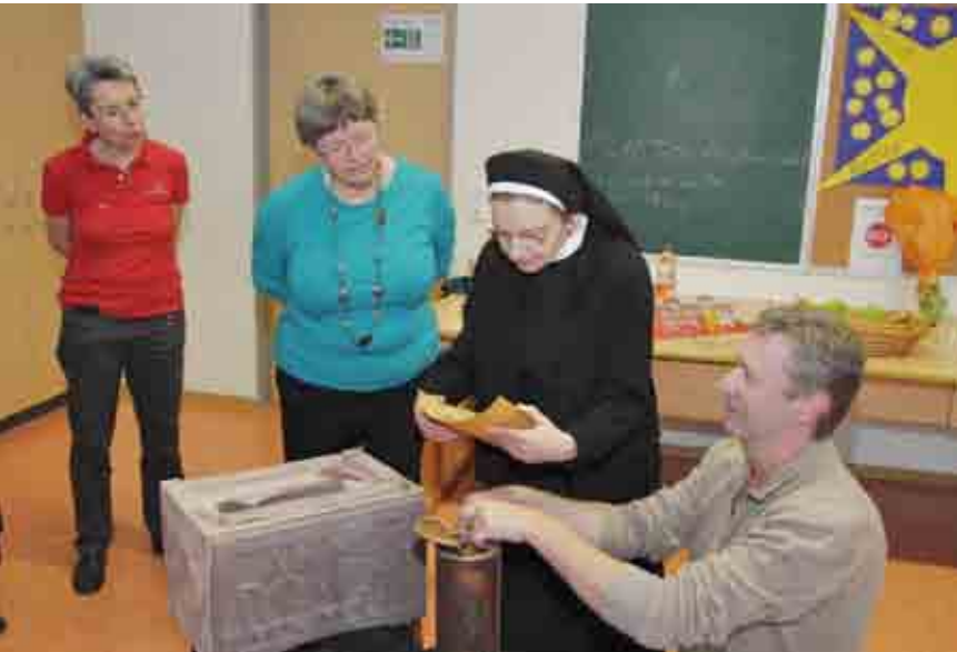
Gedrucktes und Digitales wandert in die Zeitkapsel – letzte Vorbereitungen bevor diese dann von Herrn Kneis in den Grundstein gelegt wurde.
