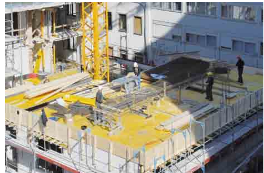
Viel Handarbeit – der Neubau nimmt Formen an
