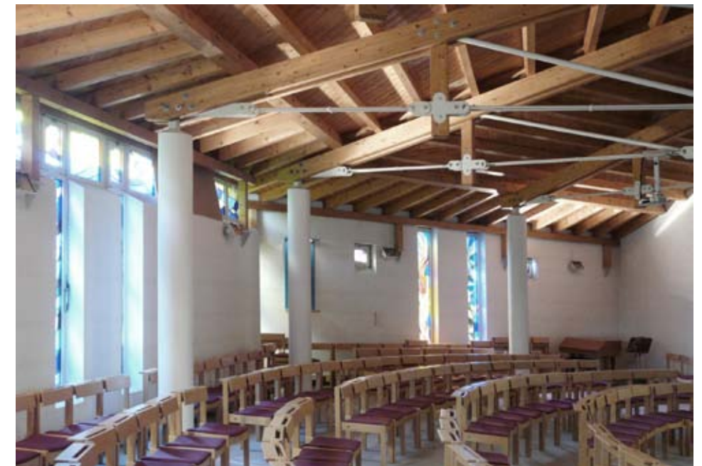
... in dessen Mitte der Altar steht. Der kreisförmige Altarraum erhält seine Helligkeit durch einen Lichtturm. Die offene Dachstuhlkonstruktion aus Holz vermittelt eine schützende Raumatmosphäre.
