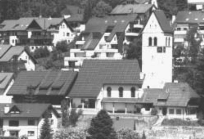
Kirchendach mit Photovoltaikanlage
